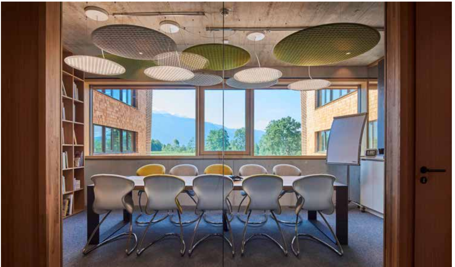
Die Kombination der LED-Pendelleuchten Modul R mit den Akustikabsorbentibus Rosso (beides Nimbus) prägt das Deckenbild des Konferenzraumes. Die Leuchten sind im Dali-Bussystem integriert und folgen in der Lichtfarbe dem Tagesverlauf der Sonne.
