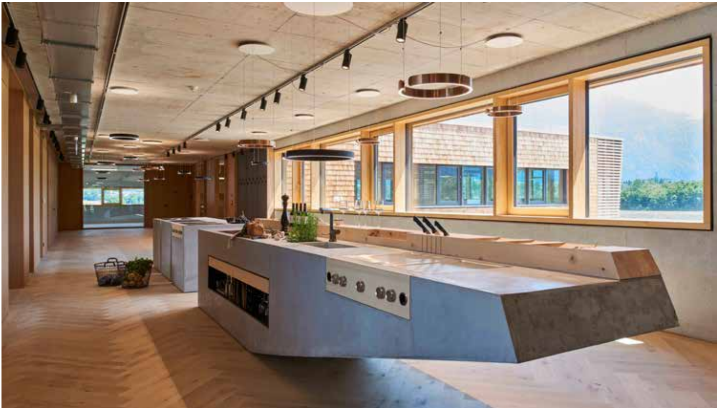
Die Spannungsversorgung der Einzelleuchten erfolgt über ein 3-Phasen-Stromschienensystem, welches auch die Strahler 2 GO zur Akzentbeleuchtung integriert.
